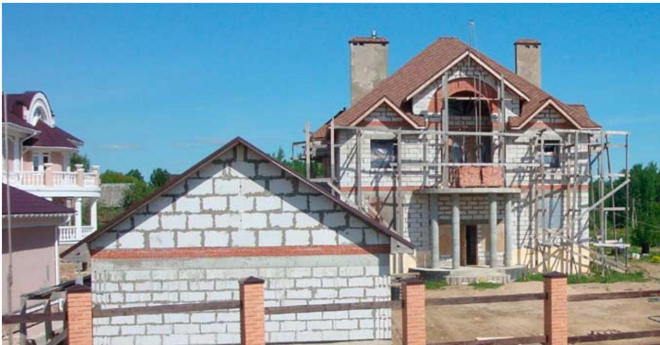
рый существует на пересечении множеств: класс бетона по прочности на сжатие В1,5 и выше (марочная прочность камня от М25), средняя плотность 500 кг/куб. м и ниже.
