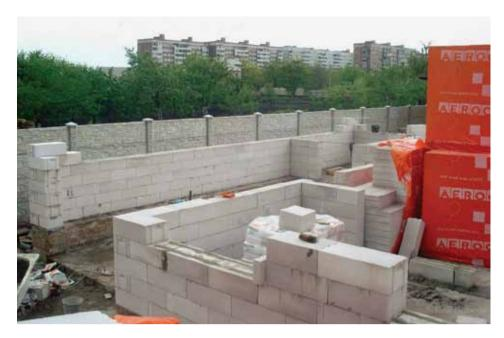
ствуют второму классу (54–120 Бк/кг), глиняный кирпич – третьему (120–153 Бк/кг). В группу материалов с высокой радиоактивностью – от 153 до 370 Бк/кг (четвертый класс) – входят керамзит и керамическая плитка. Если же пересчитывать с массы на объем, то квадратный метр газобетонной или деревянной стены имеет радиоактивность менее 2 тыс. Бк, а кирпичной – от 10 до 18 тыс. Бк.
