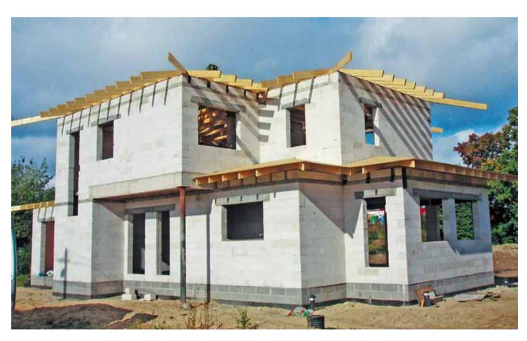
Синтетические вещества в составе газобетона отсутствуют, в этом отношении ему проигрывают даже популярные утеплители. Так, в составе минеральной ваты содержится фенолформальдегидное связующее. Такой утеплитель можно применять в строительстве, но его обязательно требуется укрывать, чтобы жильцы дома не дышали испарениями связующих веществ. В то время как открытая стена из газобетона может разве что не очень эстетично выглядеть, но никакого вреда здоровью она не несет.
