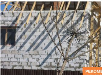
Вообще, между окончанием кладочных и началом отделочных работ следует сделать паузу от пары недель до 6-12 месяцев – в зависимости от сезона года и интенсивности дождей во время кладочных работ. И в любом случае оштукатуривание газобетонной кладки в период с ноября по март – не рационально.
