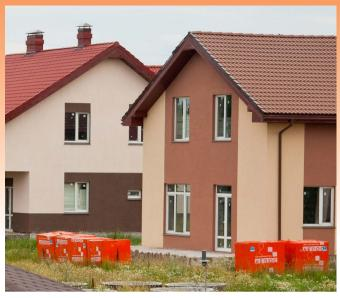
мостью. Если дело происходит осенью, и в доме включается отопление, то влага из толщи газобетона начинает мигрировать в сторону с меньшим парциальным давлением водяных паров – то есть в сторону холодной улицы. На границе газобетон-штукатурка происходит конденсация водяных паров, пограничный слой переувлажняется и при замораживании это может привести к отрыву штукатурки вместе с наружными слоями газобетона.
