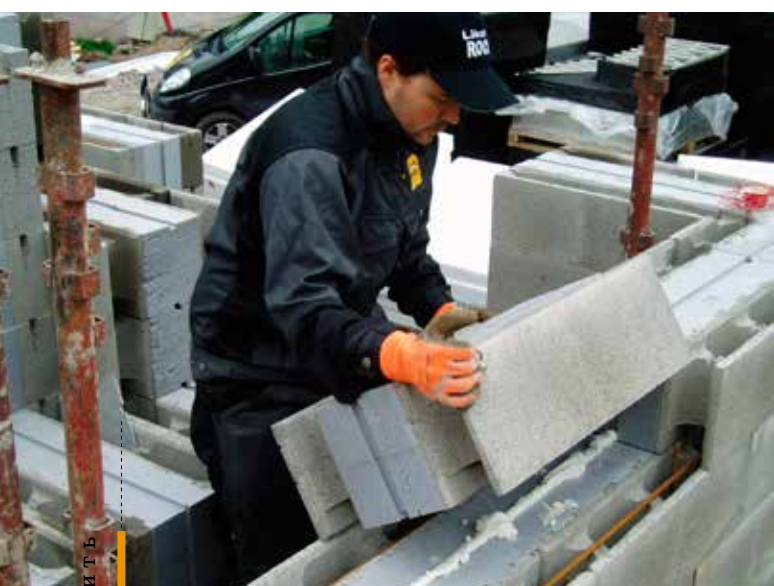
Несъемная опалубка собирается из отдельных элементов, в полости которых вставляется арматура и заливается бетон...
