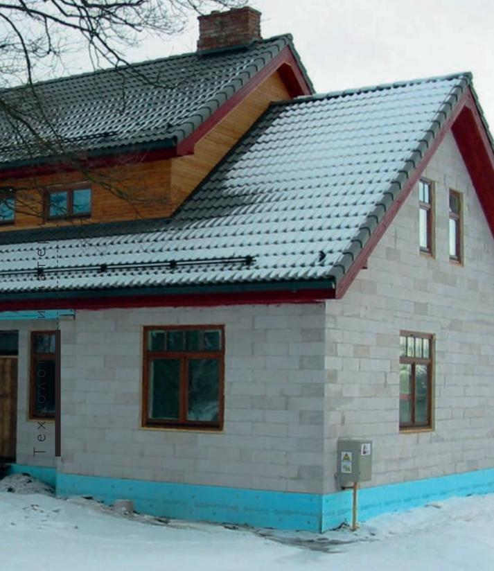
Газобетон — самый теплый из конструкционно-теплоизоляционных материалов
