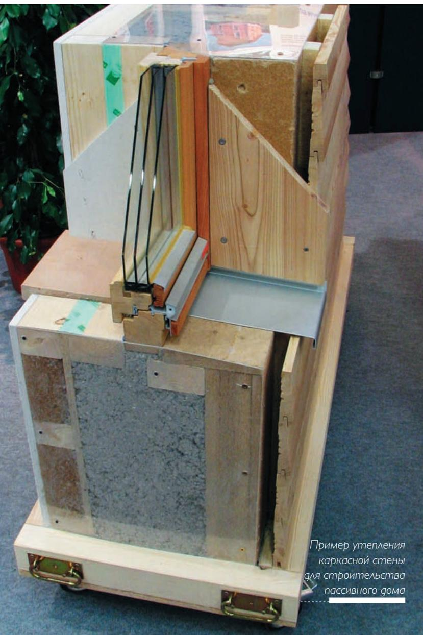
Пример утепления каркасной стены для строительства пассивного дома
