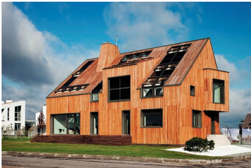
Один из самых теплых домов в мире со стенами, утепленными минеральной ватой толщиной 550 мм
