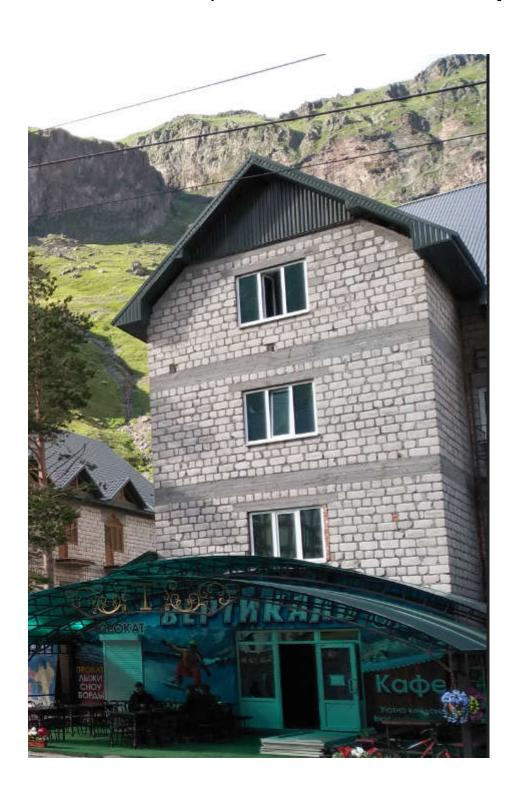
Из пеплоблоков возводится однослойная кладка толщиной 390 мм, разрезанная монолитным каркасом. Без наружной теплоизоляции.
