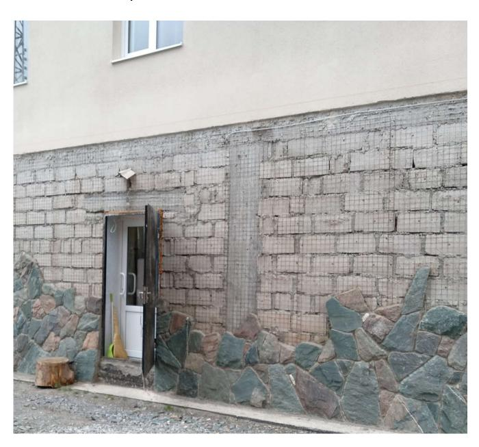
Из пеплоблоков возводится однослойная кладка толщиной 390 мм, разрезанная монолитным каркасом. Без наружной теплоизоляции.
